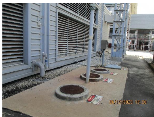
ภาพที่ 2-34 ถังบำบัดน้ำเสียสำเร็จรูป
