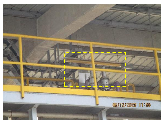
ภาพที่ 2-83 วาล์วลดความดันเพื่อป้องกันความเสียหาย ของถังแอมโมเนีย
