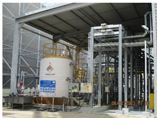
ภาพที่ 2-40 ระบบบำบัดน้ำเสียแบบเคมี
