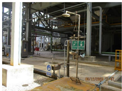
ภาพที่ 2-77 อ่างล้างตาและร่างกายฉุกเฉิน
