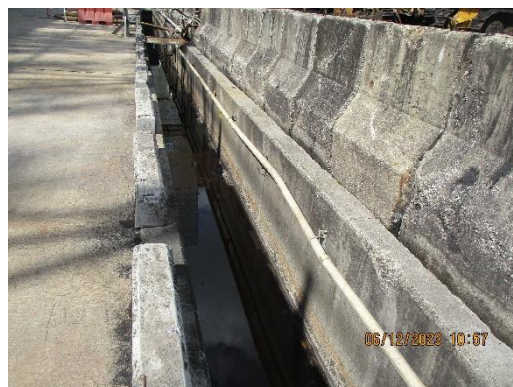
ภาพที่ 2-38 รางระบายรอบพื้นที่ลานกองถ่านหิน
