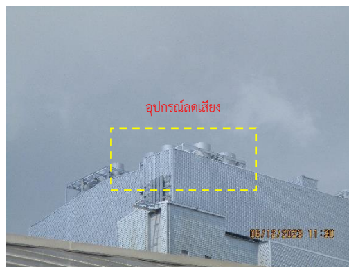
ภาพที่ 2-30 อุปกรณ์ลดเสียง (Silencer) บริเวณจุดระบายไอน้ำของหม้อไอน้ำ
