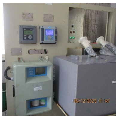
ภาพที่ 2-42 เครื่องตรวจวัดความเข้มข้นของคลอรีนในน้ำทิ้ง
