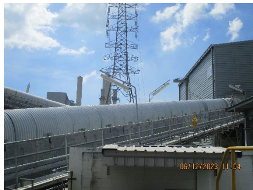
ภาพที่ 2-8 สายพานลำเลียงถ่านหินแบบระบบปิด
