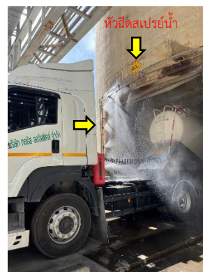
ภาพที่ 2-28 การล้างทำความสะอาดรถบรรทุกเถ้าถ่านหิน หลังการขนถ่าย
