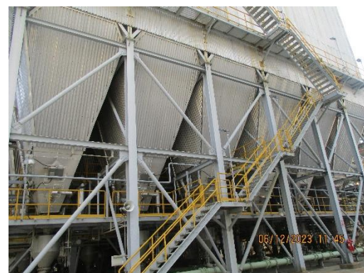
ภาพที่ 2-18 อุปกรณ์ดักฝุ่นละออง (ESP)
